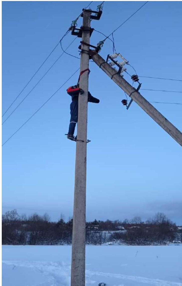
В 15:40 диспетчеру Удомельского РЭС поступила информация от электромонтёра 2 о том, что электромонтёр 1 попал под напряжение, поднявшись на опору № 126. Диспетчер, совмещающий обязанности дежурного электромонтёра ПС 110 кВ Удомля, произвел аварийное отключение ВЛ № 15 ПС 110 кВ Удомля и ВЛ № 18 ПС 110 кВ Удомля с последующим выводом ВЛ
